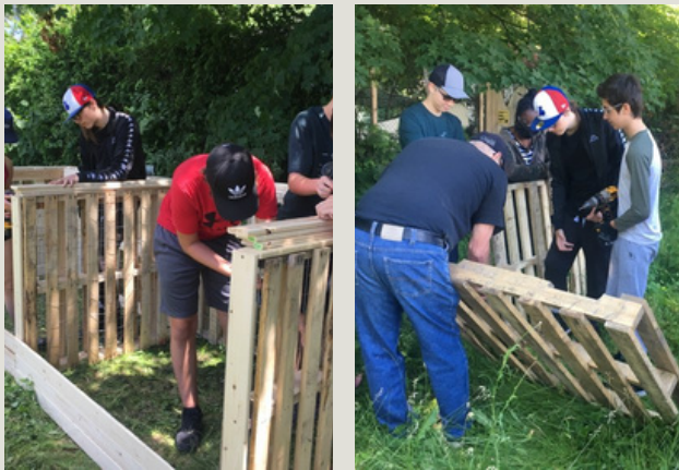
Construction de bacs à compost (stage été 2022)
